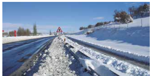
Elementos de contención
