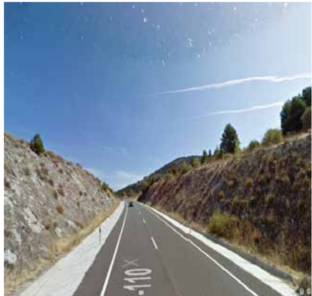
Calzada en trinchera
