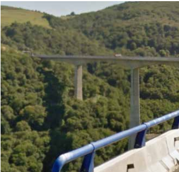
Tramos de calzada que atraviesan viaductos
